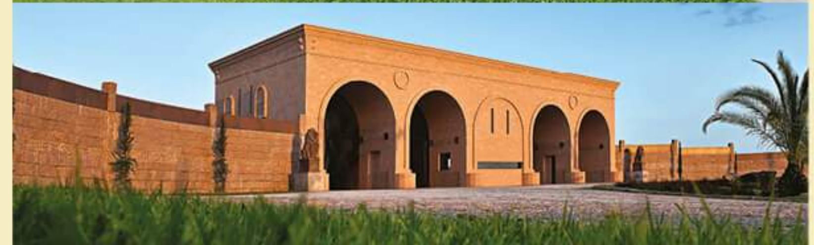
Cabeamento subterrâneo | Portaria blindada
